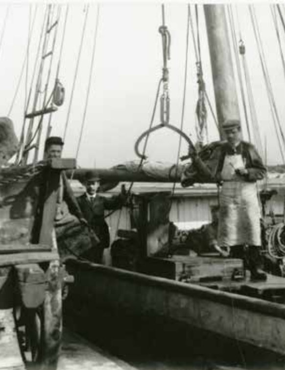
Limonadefabriek Donny Gent / Boven: Lossen van een ijschip. De ijsblokken werden met een hijsstelsel met tang op de kar van de firma Donny geladen. F02028 / Onder: Lossen van ijsblokken op de kar van de brouwerij en frisdrankenhandel Donny (MIAT). F02026
